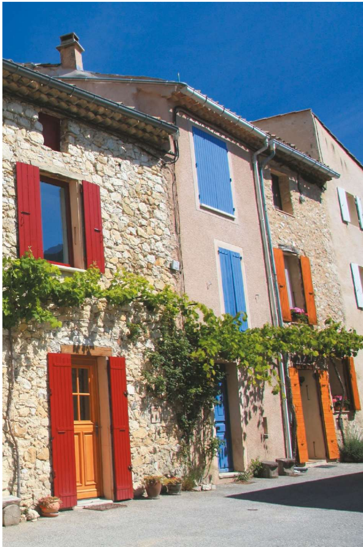
Volets bois lames verticales, 27 mm d'épaisseur. < Pas de lames 90 mm.
